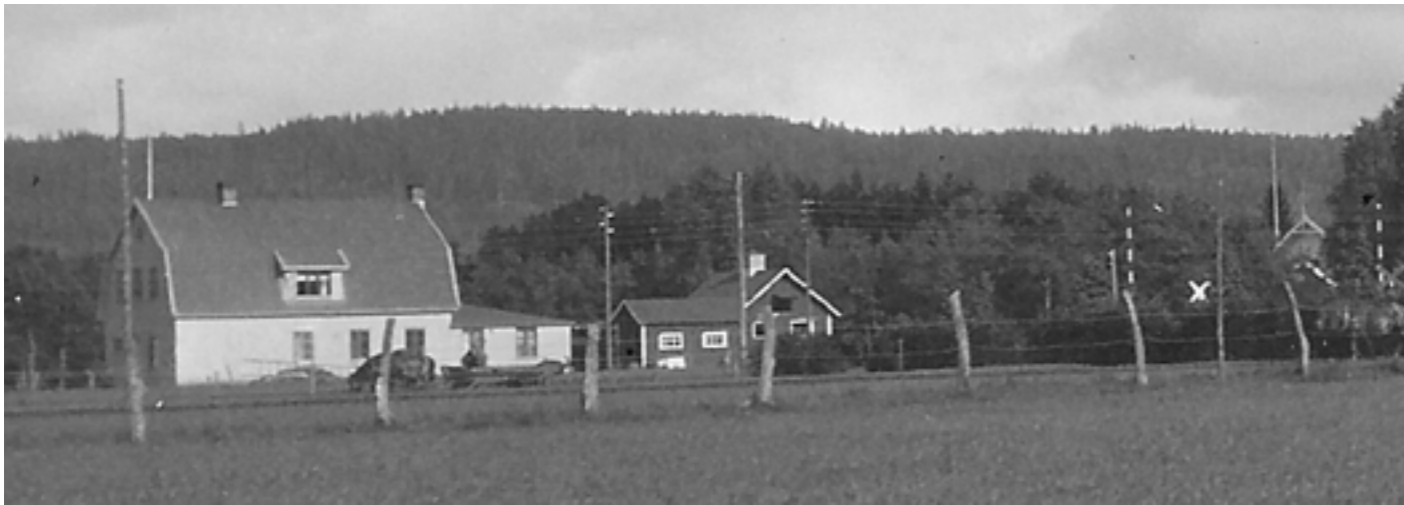
Här en bild på Jaegersfabrikens västra sida, tagen före den omtalade utvidgningen av lokaliteterna. Om huset byggdes till och hur det därefter såg ut, är oss obekant. Järnvägen kan skönjas och bommarna som stängde Lenavägen ses till höger. Byggnaderna till höger om fabriken kan vara uthus och ev. ett bostadshus. Lägg märke till hästekipaget framför fabriksbyggnaden.
