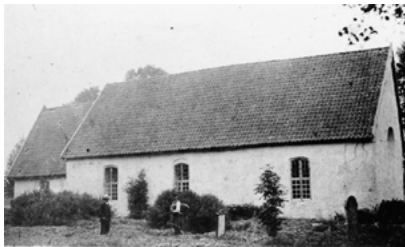
Brunns kyrka 1893, före rivningen
